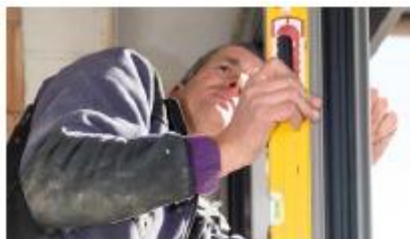
14 CONTROLLARE ANCORA L'ALLINEAMENTO DELLA FINESTRA
