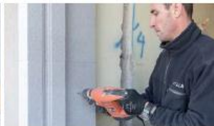
9 ESEGUIRE LA FORATURA NEL MURO
